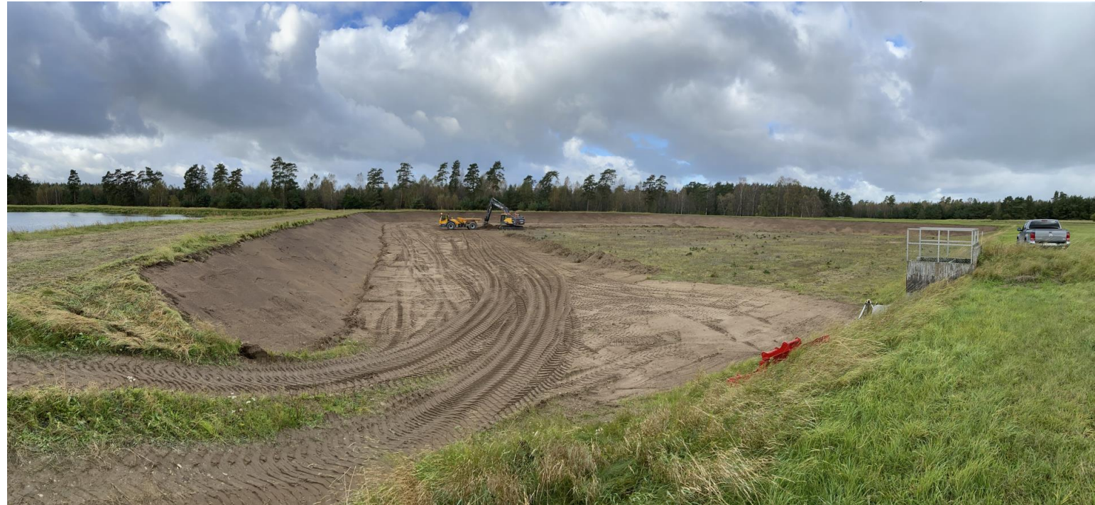
Renovering av Damm 11
