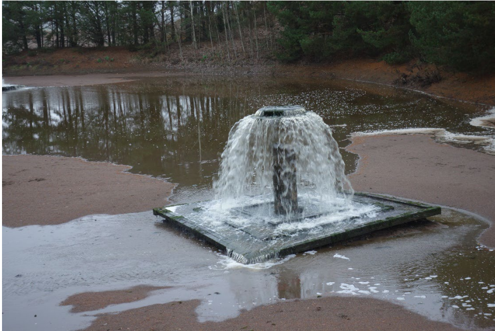
Bild 3: Konstgjord grundvattenbildning genom infiltration på en rullstensås med vatten från ett närläget vattendrag. Fotograf: Bo Olofsson
